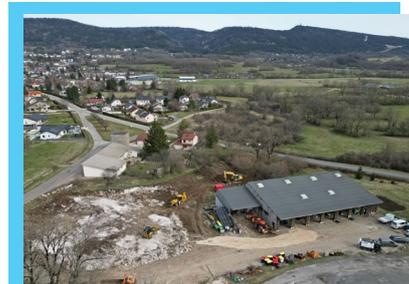
**Plateforme pour l'implantation d'un hangar photovoltaïque de stockage de matériel au Centre technique municipal de TREPONT** (Réalisation par les Services Techniques avec location de matériels - Pelle mécanique - Brise roche).
