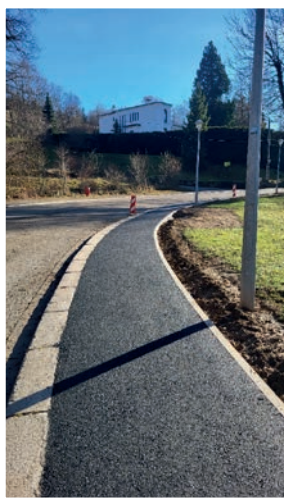
Trottoirs et voies douces Rue du 11 Novembre et du 8 Mai 1945
